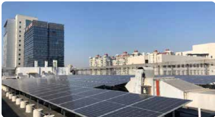
太保产险 929 园区完成低碳节能改造工程
