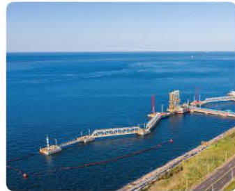
天津港口枢纽基础设施建设项目
